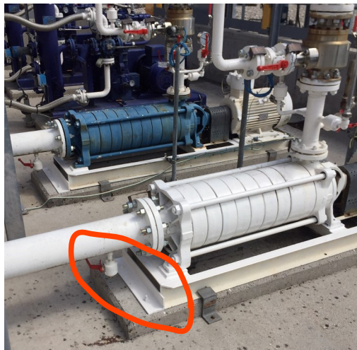
Figure 1: Ancrage des pompes du RST
