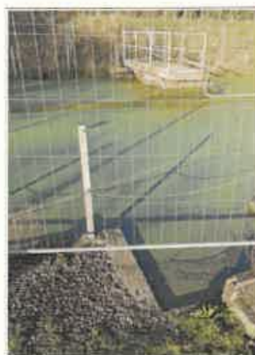
Photos n°2 et 3 : Bassin non sécurisé (risque de chute) – grille non installée
