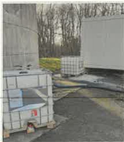
Photos n°6 et 7 : Absence de rétention sur des « IBC » contenant des polymères.
