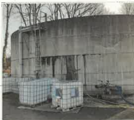
Photos n°6 et 7 : Absence de rétention sur des « IBC » contenant des polymères.
