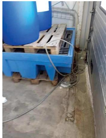
**Les surfaces du local extérieur apparaissent dégradées par endroits. Par ailleurs, au niveau de cette zone extérieure 8 fûts sont stockés hors rétention sur palettes, ainsi que des bidons d'environ 25L non étiquetés et un bidon d'huiles usagées étiquetées sous le nom du contenu initial du bidon, à proximité immédiate d'un regard de réseau d'eaux pluviales.**
