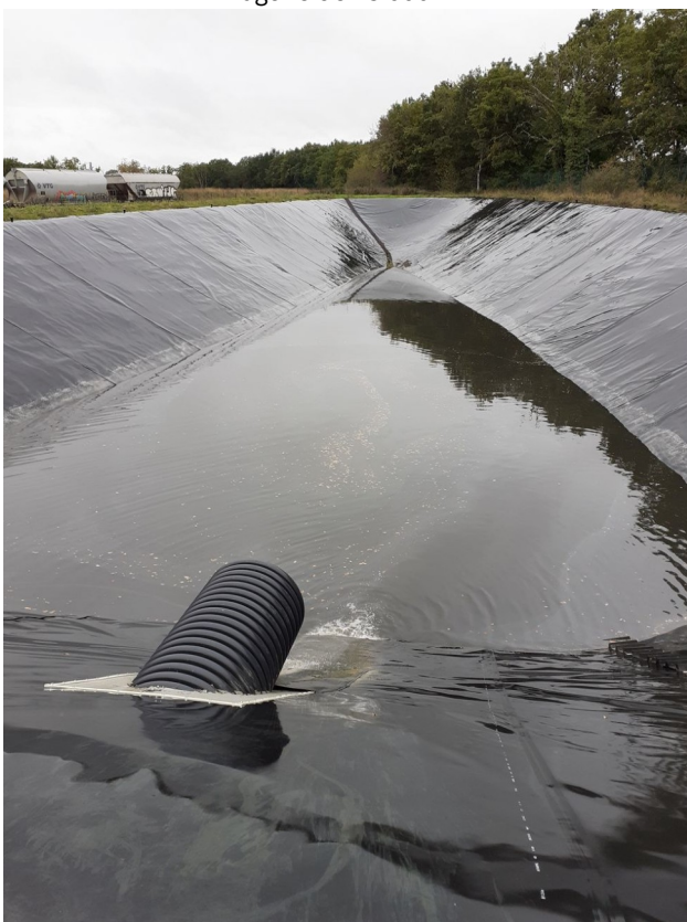
Bassin étanche au nord-ouest du site
