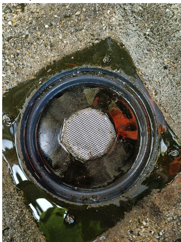
Exemples de filet en plastique (à gauche) et de panier métallique (à droite) sur des avaloirs
