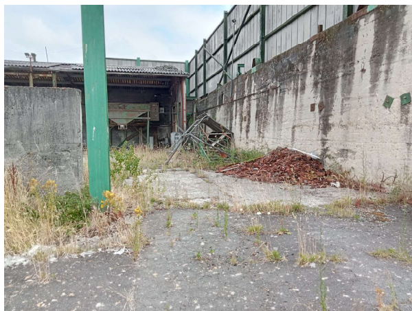
Fig. 7 Tas de ferraille près du mur de droite
