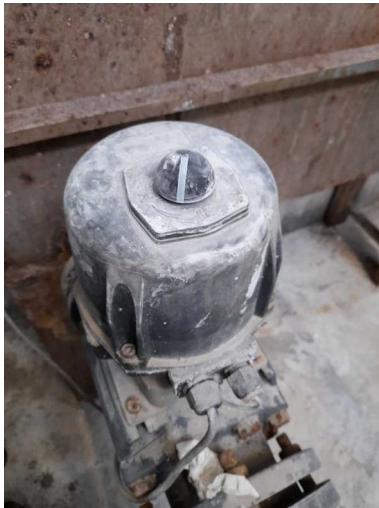
Vanne motorisée en cours de fermeture
