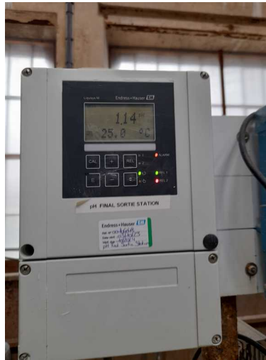
PH mètre en défaut (déclenchement manuel pour test)
