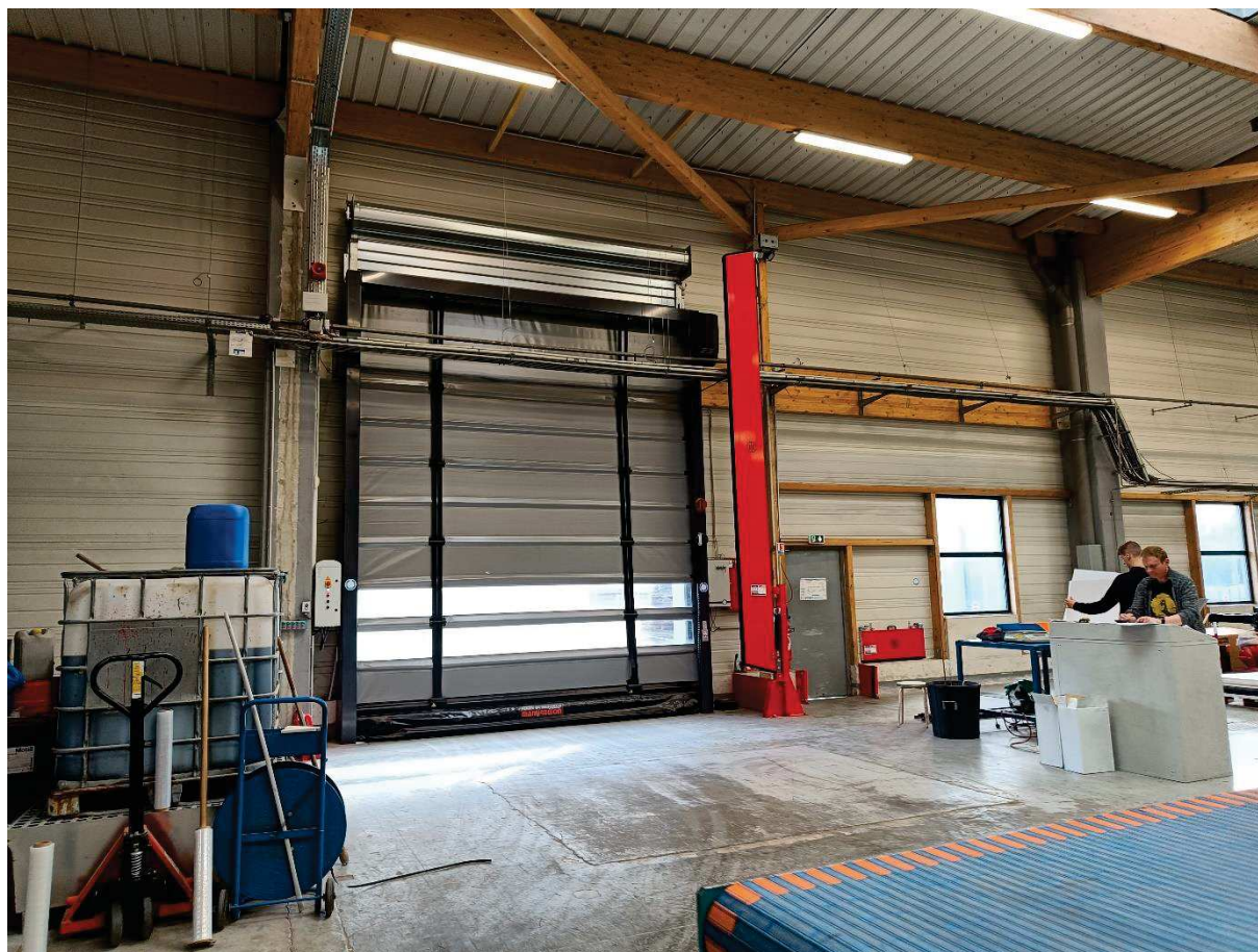
Figure - Pose des barrières pour mettre le bâtiment en rétention
