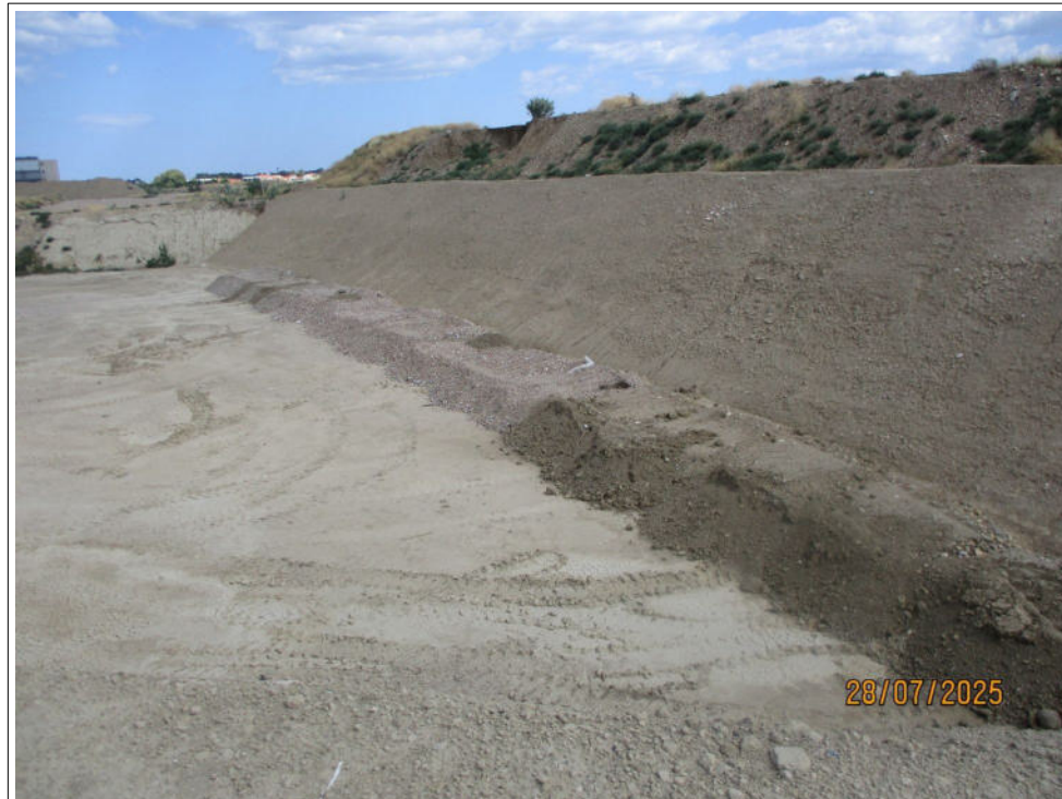
Déchets de MCA stockés dans le casier n° 3, recouverts de matériaux non dangereux inertes
