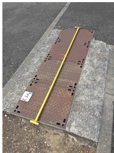
Sécurisation accès puits PF2 (photo transmise par l'exploitant - courriel du 09/09/2022)
