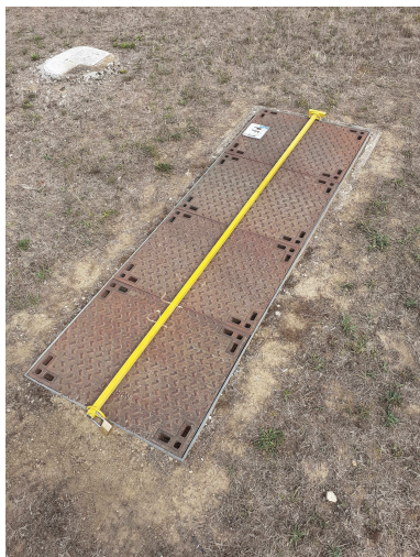
Sécurisation accès puits PF1 (photo transmise par l'exploitant - courriel du 09/09/2022)
