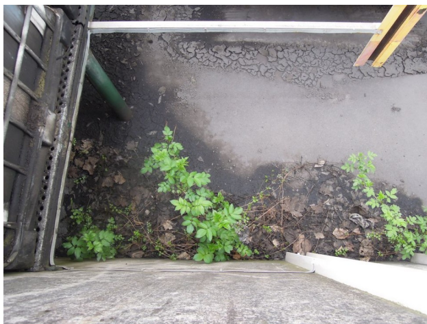
Cuvette de rétention du réservoir horizontal de FOD
