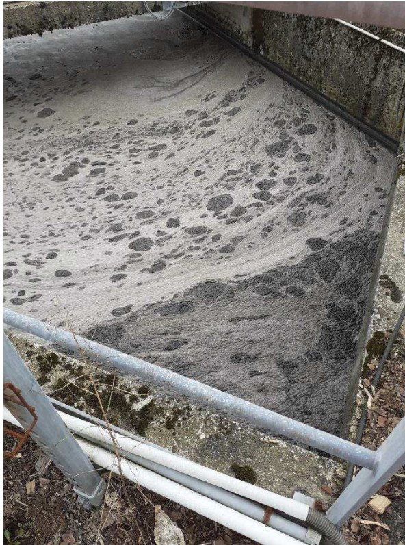
Figure 11 : Ce bassin, normalement vide, est rempli (fuite) et présente des matières en surface. L'odeur est désagréable.
