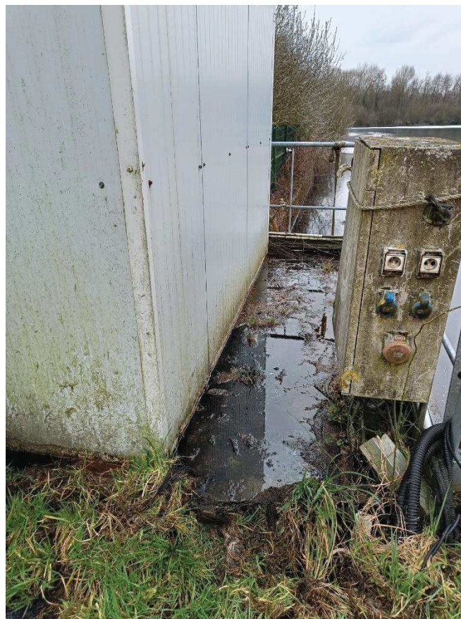
Figure 12 : Le sol, autour de l'abris des pompes est recouvert d'eau sale
