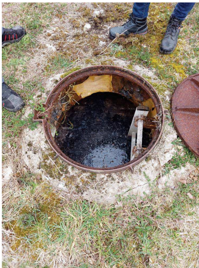
Figure 5 : Second regard du séparateur hydrocarbures
