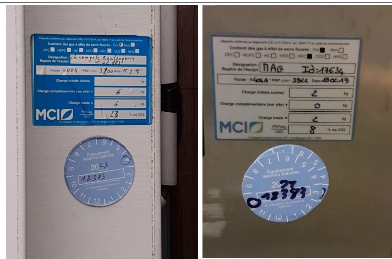
L'exploitant doit s'assurer qu'après chaque contrôle périodique d'étanchéité une nouvelle vignette soit apposée sur les équipements avec la nouvelle date limite de validité.
