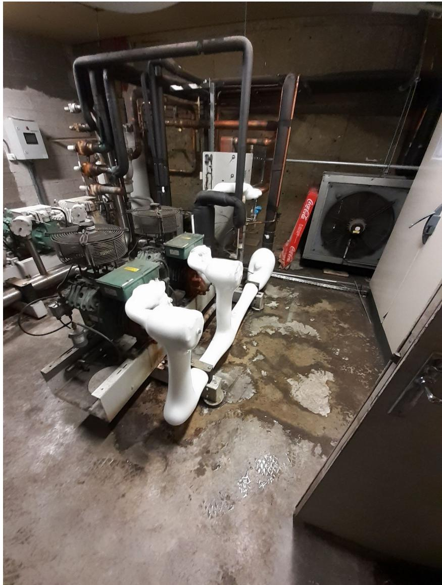
L'exploitant doit mettre en place les actions nécessaires pour qu'il n'y ait pas de glace sur la calorifugeage de la centrale froid. Le technicien de maintenance a indiqué qu'un devis a été réalisé pour une intervention sur la centrale froid.
