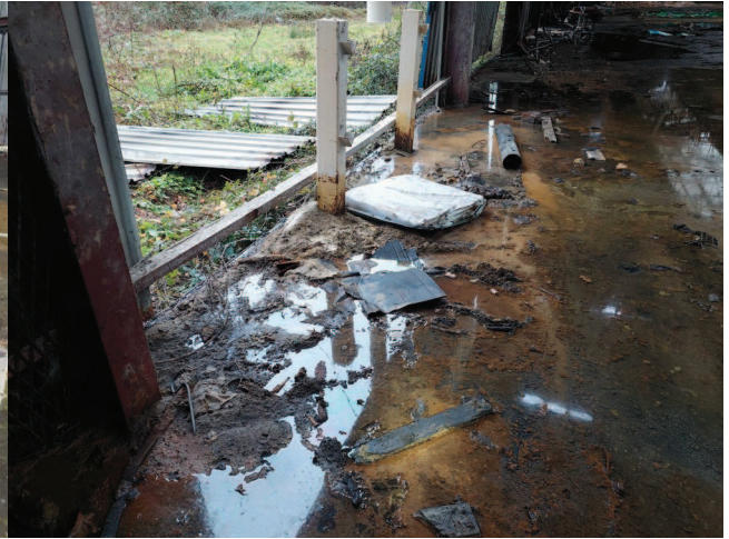
Ecoulement vers l'extérieur de déchets liquides contenus dans les fosses du local HA1009B
