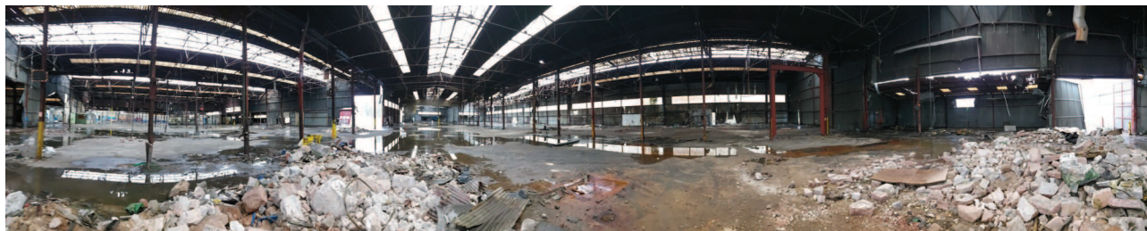
Vue panoramique de l'intérieur de l'atelier (locaux HA1007B, HA1008B, HA1009B, HA1010B, HA1006B, HA1005B et HA1004B). Infiltration d'eau météorique depuis la toiture endommagée. Gravats rentrés dans les locaux visibles en premier plan.
