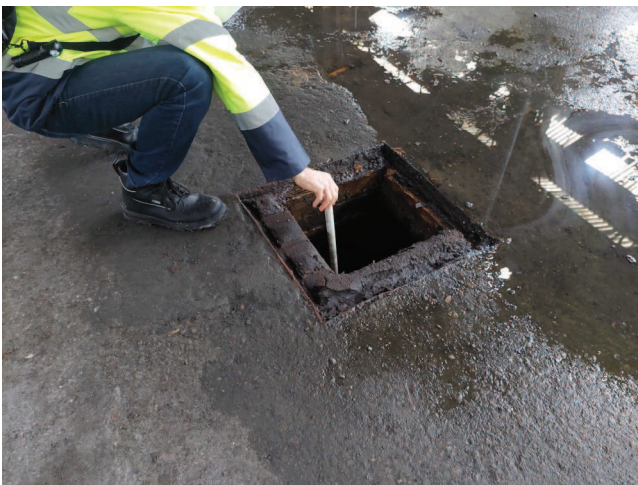
Regard rempli de déchets liquides, avec infiltrations sous dalle en profondeur (local HA 1002B)
