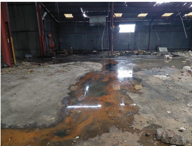
Ecoulement de déchets liquides repris par les eaux météoriques au niveau du local HA1007B
