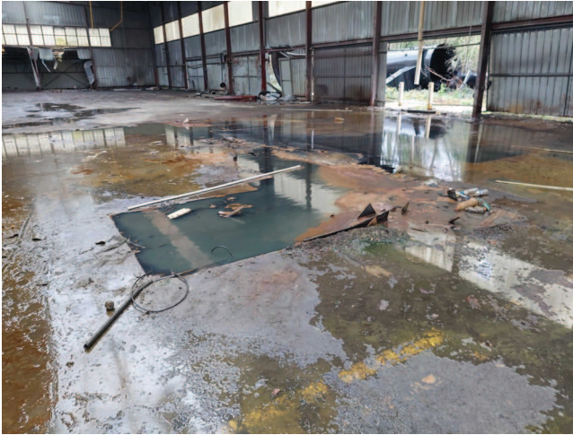
Ecoulement vers l'extérieur de déchets liquides contenus dans les fosses du local HA1009B
