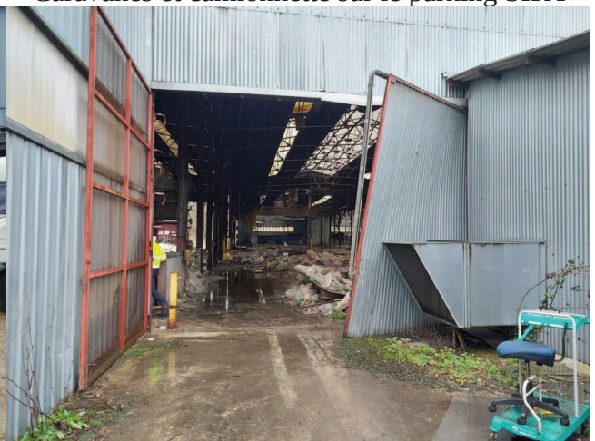
Bardage arraché au niveau du parking SIFA
