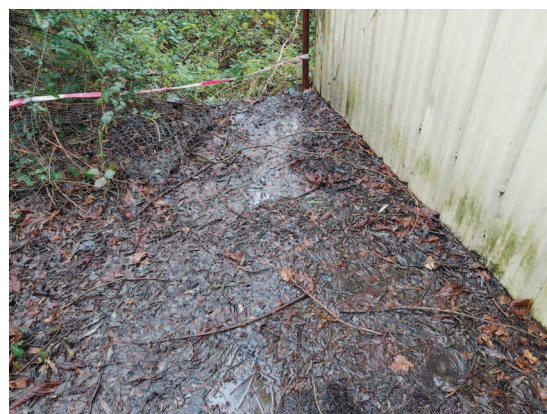
Ecoulement des déchets liquides à l'extérieur du local HA1009B
