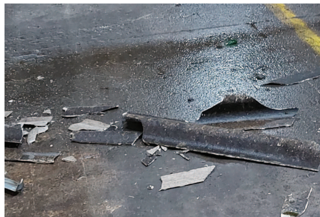
Toiture en fibro-ciment (probablement amiantée) effondrée
