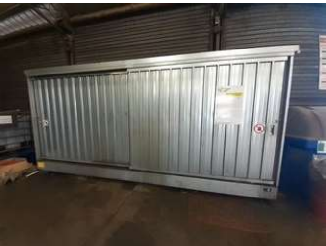
Armoire de stockage des produits chimiques équipée de rétention
