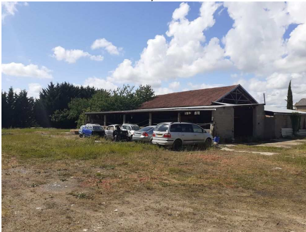
6 véhicules sont stockés à l'extérieur du bâtiment sur les parcelles 0672 et 0673.
