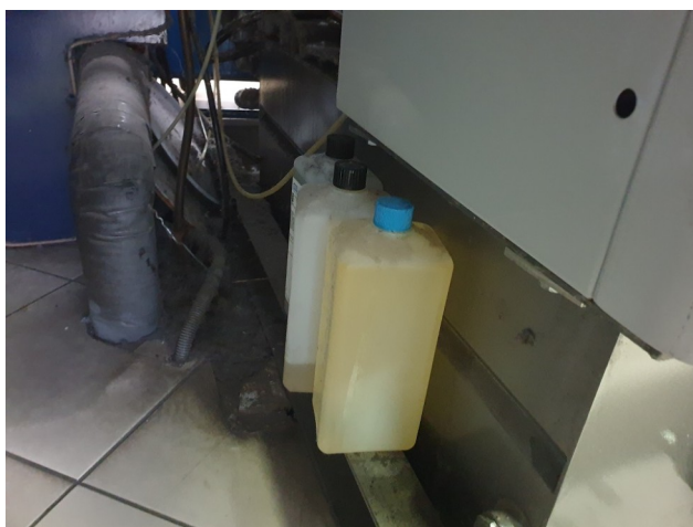
Photo n°2 : Stockage des produits chimiques liquides hors rétention
