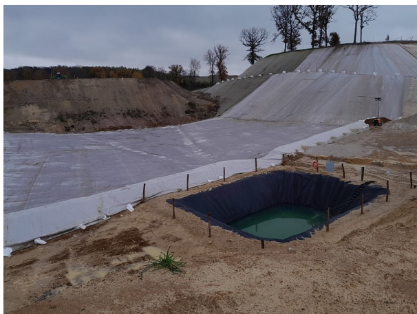
Vues du casier préparé et du bassin de stockage des eaux de ruissellement internes (cliché UD95)
