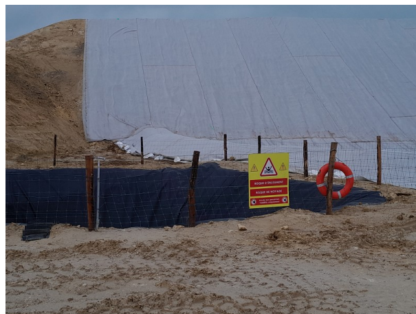
Vues du casier préparé et du bassin de stockage des eaux de ruissellement internes (cliché UD95)
