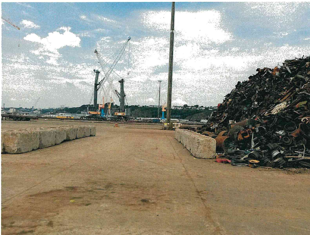
Photo 3 : bande de 5 m entre les 2 tas, maintenue libre à l'aplomb de la canalisation, délimitée par des blocs béton positionnés au sol.
