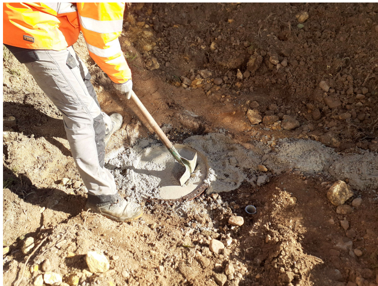
Fin de l'inertage au béton
