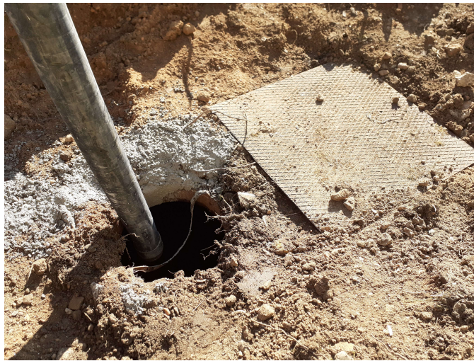
Compartiment en cours d'inertage (béton)
