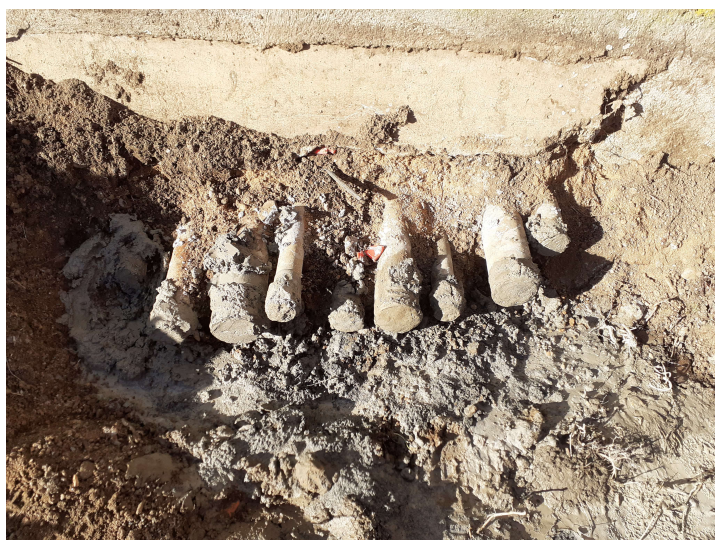
Canalisations sectionnées et remplies de béton
