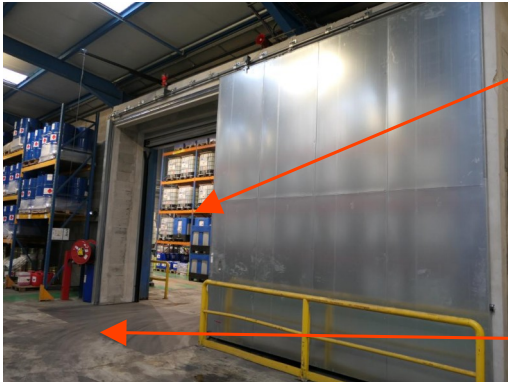
Bâtiment 3, stockage d'acides en GRV
