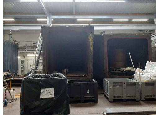
Démontage et nettoyage des portes des enceintes
