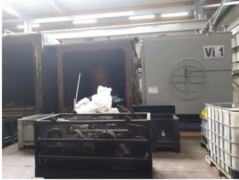
Démantèlement en cours des enceintes
