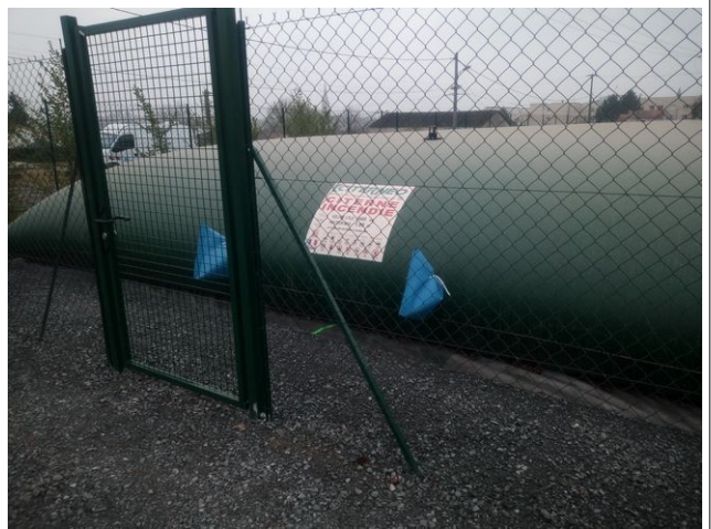
Citernes mises en place pour répondre au besoin en eau d'incendie
