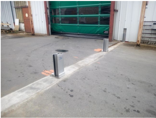
Batardeaux répartis au niveau des ouvertures de l'établissement, disposés afin de permettre la mise en rétention de l'établissement en cas de sinistre
