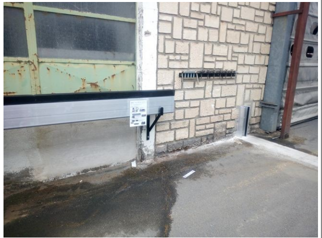
Batardeaux répartis au niveau des ouvertures de l'établissement, disposés afin de permettre la mise en rétention de l'établissement en cas de sinistre
