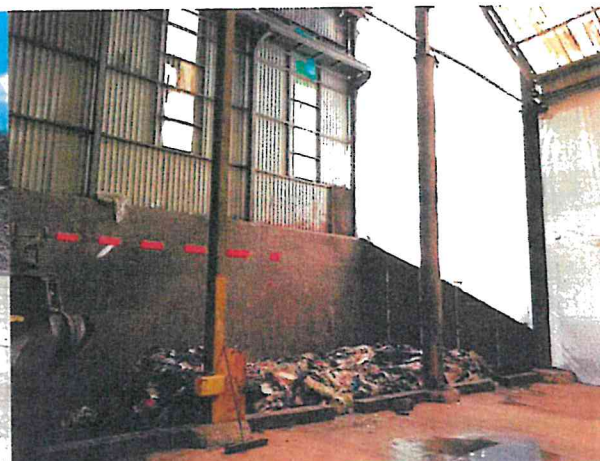
Photo 4 : vue intérieure du hall montrant la plaque limitant la partie maçonnée de la fosse et la bâche fermant le hall pendant la durée des travaux. NB : le trait rouge repere la limite haute de l'entreposage en fosse.
