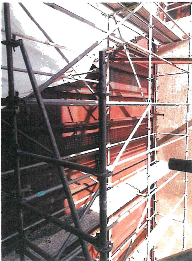
Photo 5 : vue extérieure de la paroi métallique amovible limitant la capacité de la fosse.
