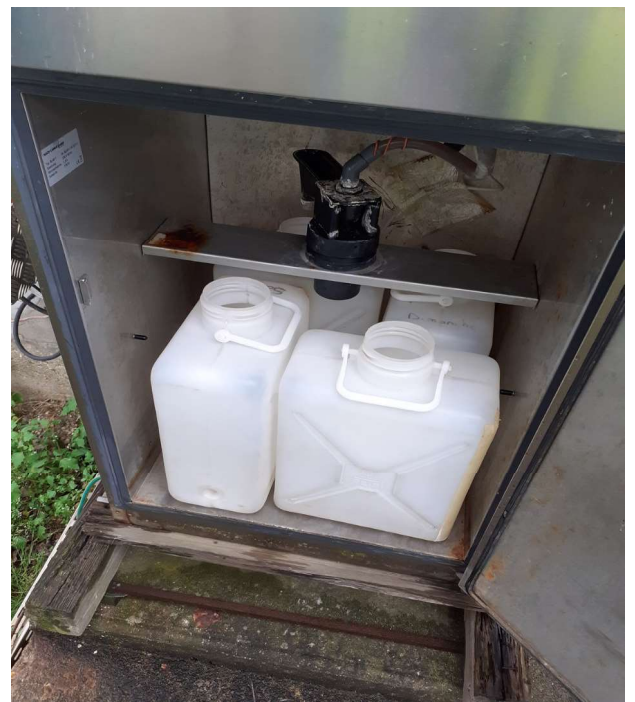
Fuite au niveau du répartiteur à remplacer par un tuyau en téflon
