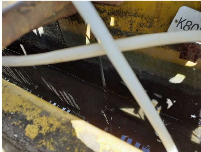
Encrassement de la sonde de type "bulle à bulle"
