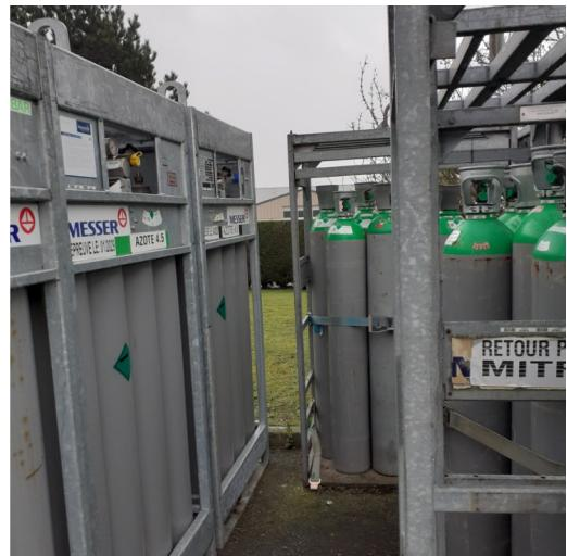
Les gaz comburants et inflammables sont séparés par des gaz neutres, permettant de respecter une distance minimale de 8 m.
