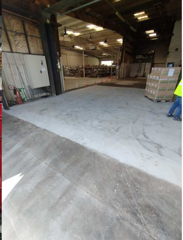
ancienne zone trempe
