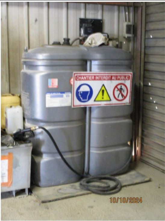
Cuve double enveloppe de gazole non routier
