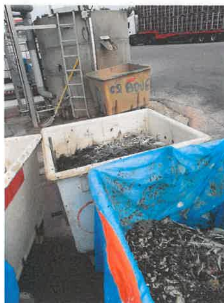
Débordement des graisses du bac de collecte
