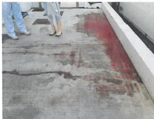
Stagnation à l'extérieur des jus de process après bouchage de l'évacuation dans le mur
