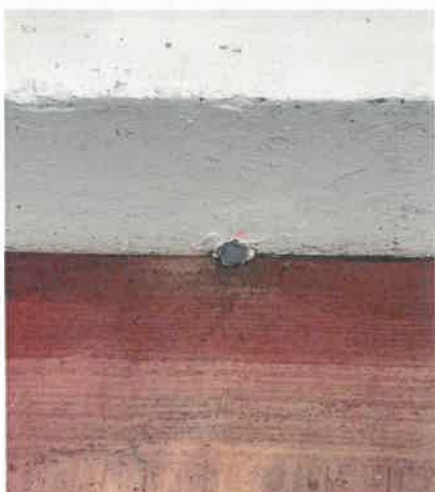
Bouchon sur l'évacuation des eaux stagnantes
