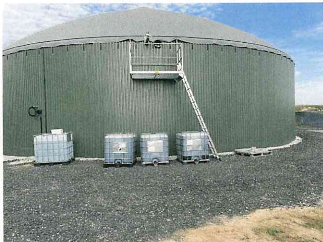
Entreposage de trois cuves de chlorure de fer sans dispositif de rétention. La quatrième cuve contient de l'eau minéralisée.
