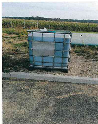
Quatrième cuve de chlorure de fer sans dispositif de rétention.
