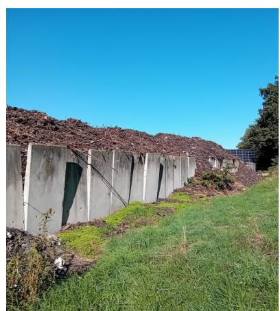
**Demande à formuler à l'exploitant à la suite du constat :** L'exploitant doit, sous 3 mois, assurer la maintenance du site en repositionnant les blocs de béton nécessaires au maintien du compost et en évacuant du site l'ensemble des objets et matériaux présents qui ne sont pas indispensables à son activité.
