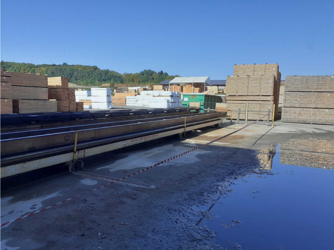
Annexe 3 : photo illustrative d'un défaut de confinement des égoutures de produit biocide issues des bois sortant de l'autoclave
