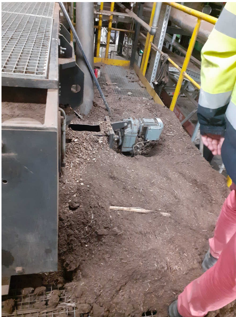
Annexe 2 : photo illustrative du défaut d'entretien de la zone d'alimentation en combustible de la chaudière à cogénération
