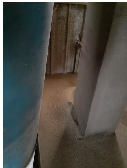
Aux étages supérieurs il est constaté un niveau d'empoussièvement globalement acceptable pour les plateformes de circulation mais des dépôts importants sur les zones difficiles d'accès pour le nettoyage (photo ci-dessous prise depuis la plateforme du dernier étage).
