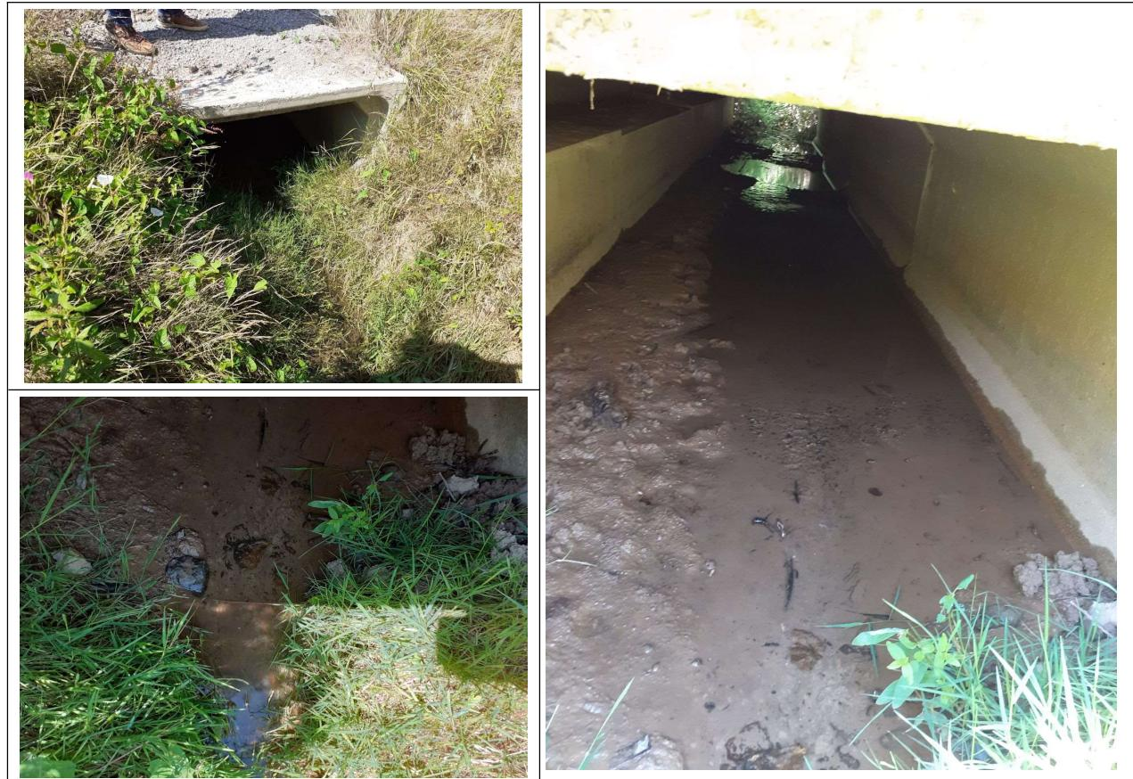
La largeur intérieure est d'environ 1,5 m, à vue d'oeil. Sa longueur est d'environ 9 m. Nous n'avons pas vu d'érosion. Les cotes de fond sont régulières, avant, dans et l'après l'ouvrage. Nous n'avons pas identifié de non conformité.
