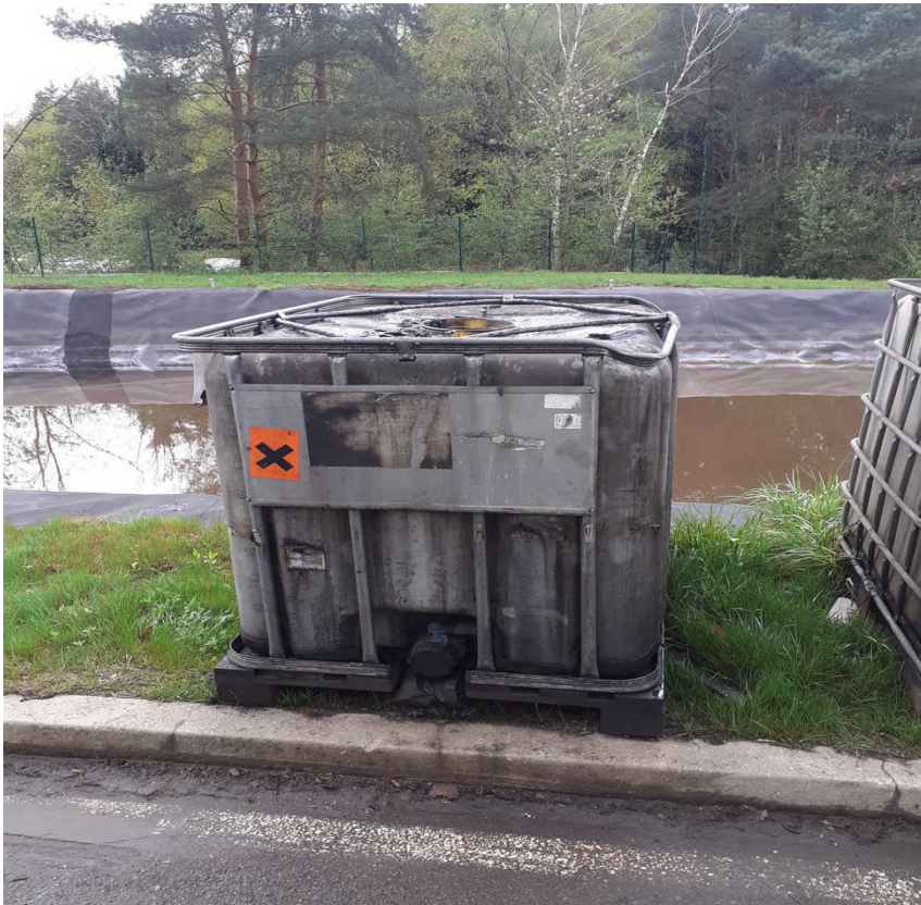
Figure 1: Fût d'hydrocarbures stocké hors rétention et exposé aux intempéries
