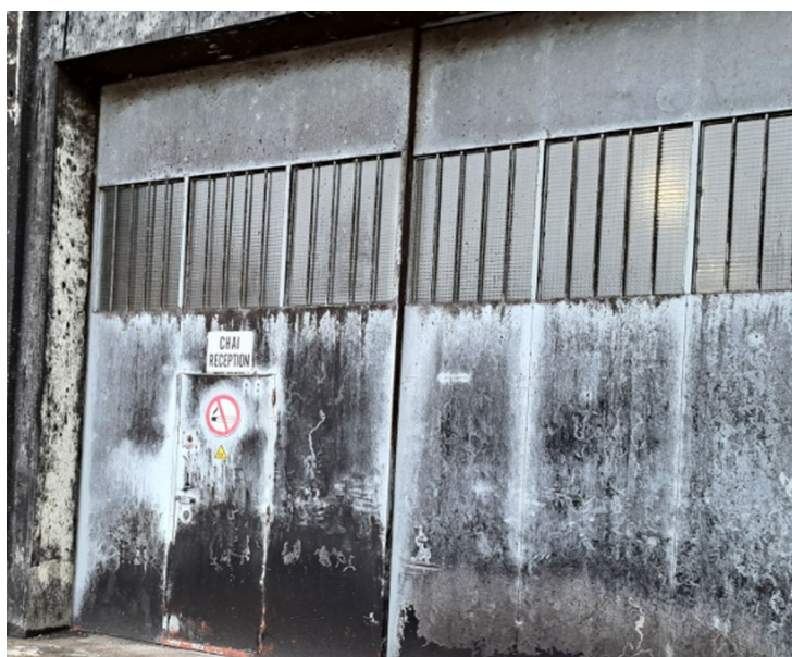
Porte comportant des surfaces vitrées
