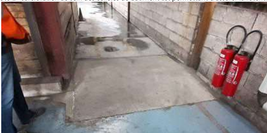
Photo 2 - surélévation au sein des cellules du bâtiment Est permettant d'assurer la rétention
