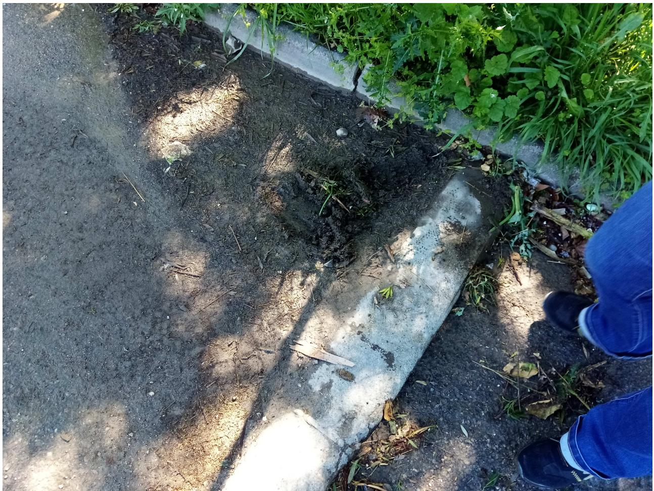
Structure de la bordure endommagée ne permettant pas de retenir les eaux d'incendie
