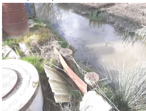
Photographie 2. Dispositif de rejet d'eau vers le milieu naturel (vidange des cannes en cas de fort gel)
