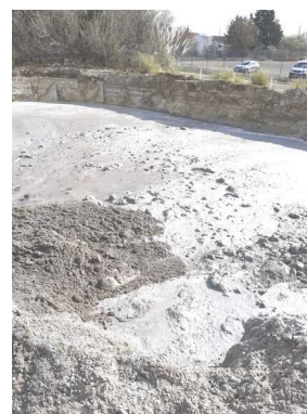
Photographie 6. Bassin de séchage des boues des bassins de décantation
