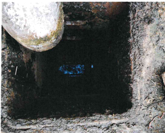
6 Regard de récupération d'eau pluviales de toiture
