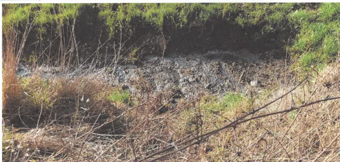
PHOTO 7 : regard d'évacuation des bassins de décantation - bouché
