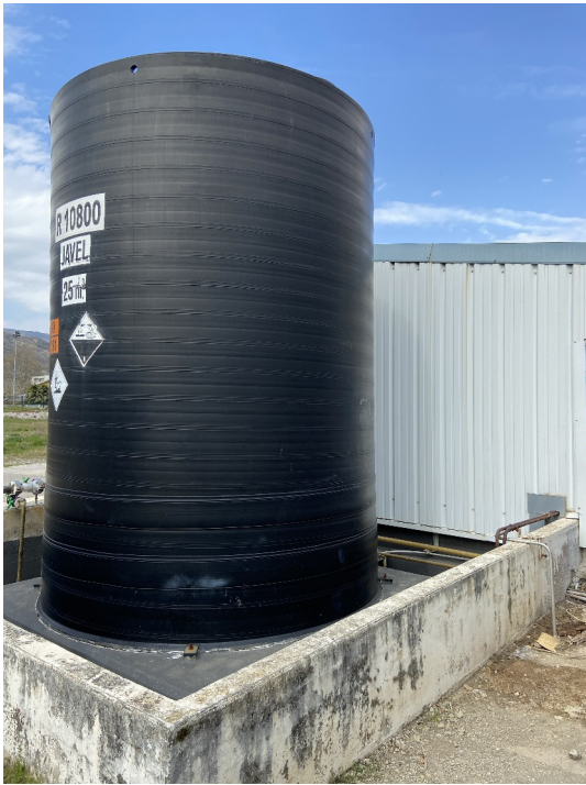
Réservoir de Javel sur rétention et sa tuyauterie vers la station de pompage
