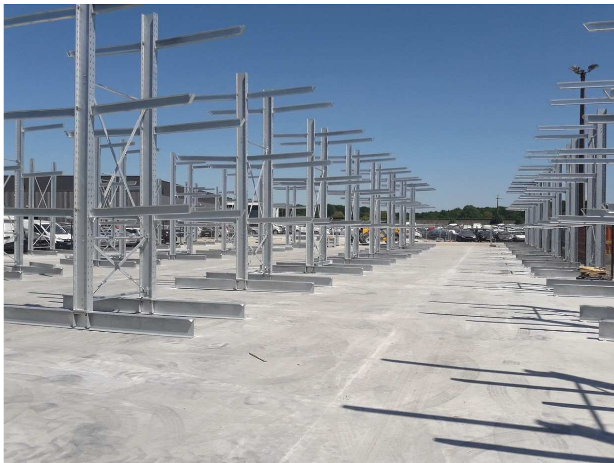
Racks d'accueil des véhicules sur 4 niveaux
