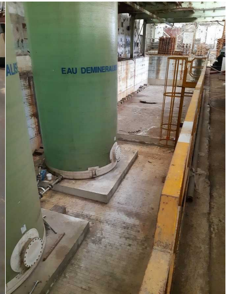
La rétention du magasin appelée « piscine »
