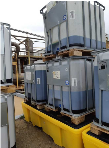
3 GRV entreposés à côté de la STEP sur une rétention prévue pour 2 GRV
