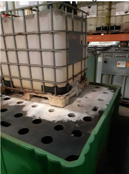
GRV fuyard sur rétention mobile dans le magasin
