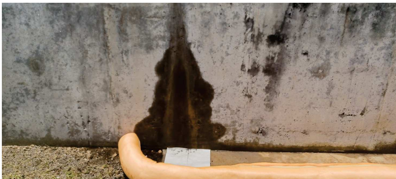
Photo : trace de suintement de produit au niveau de la rétention n°1 + boudin absorbant mis en place
