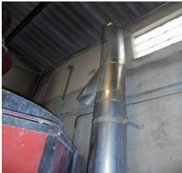
Partie de toiture rénoverée, nouvelle cheminée
