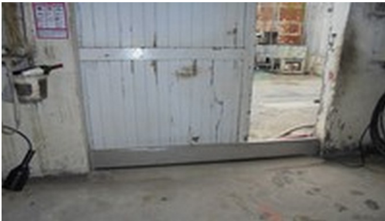
Seuil de l'ouverture principale avec joint noir intact
