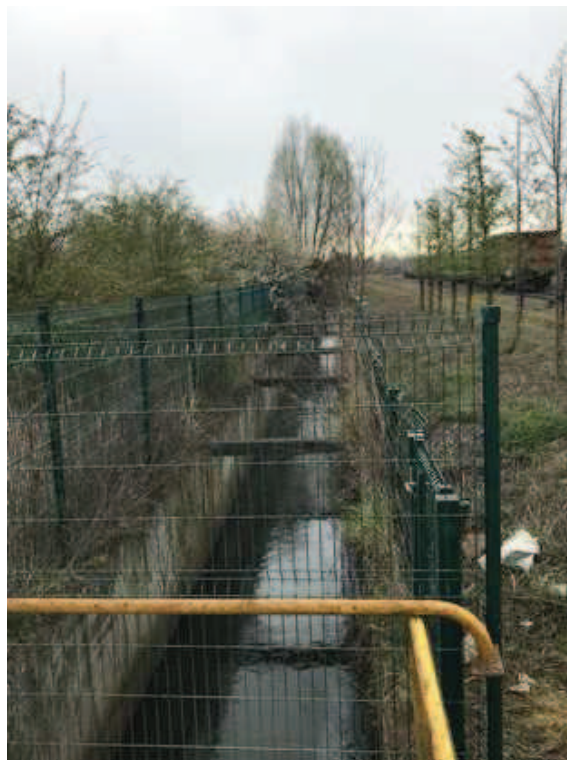
Confinement des eaux d'extinction incendie
