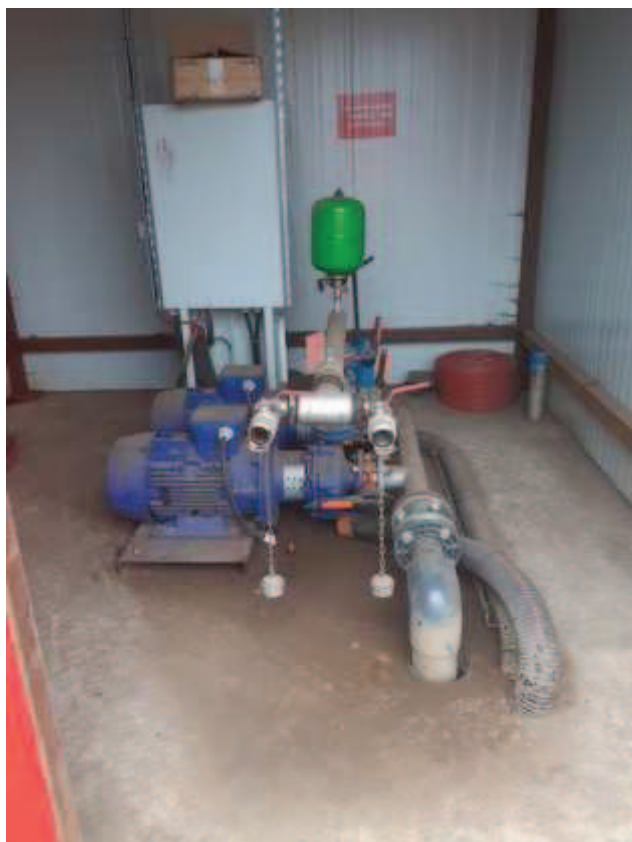
Motopompe associée à la réserve d'eau d'extinction incendie de 500 m 3
