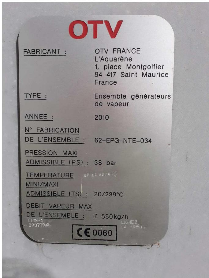
Photographie de la plaque d'identification du récipient à pression simple:
