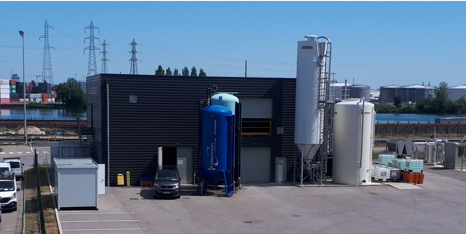
Le bâtiment de la station de traitement des eaux du site
