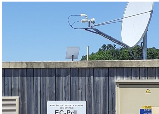
Antenne communication avec le réseau Starlink (distincte de la communication SIEMENS-GAMESA)
